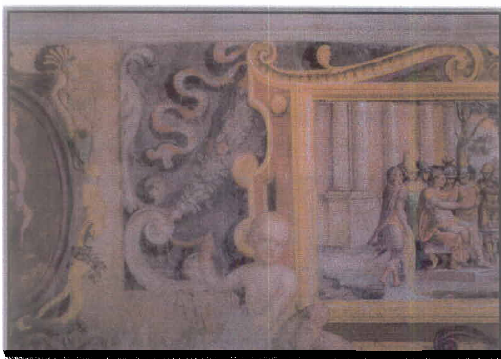
Foto 1 - Particolare del soffitto ligneo e delle decorazioni pittoriche di una sala secondaria
